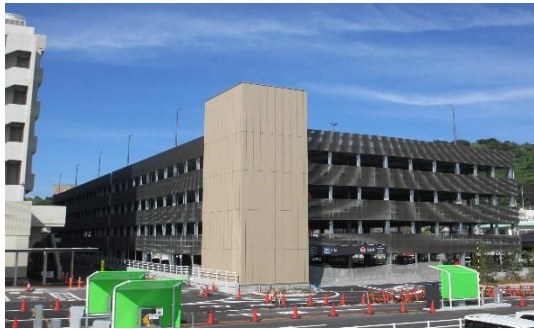
＜北立体駐車場＞
