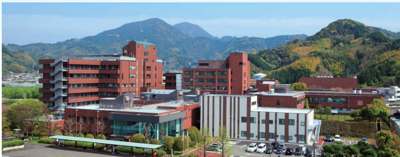
向って右手前の白壁の建物が新外来棟
