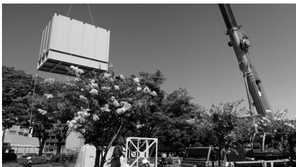
本館非常用発電機更新工事
