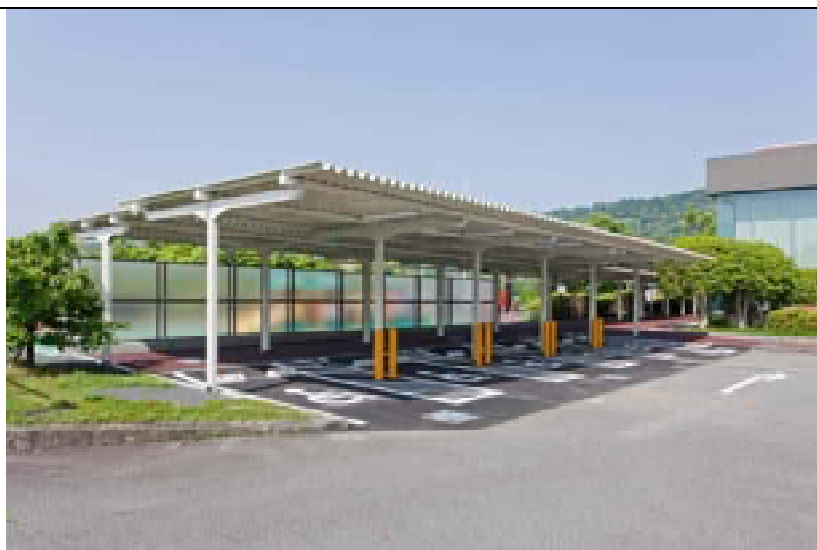
駐車場への屋根設置工事
