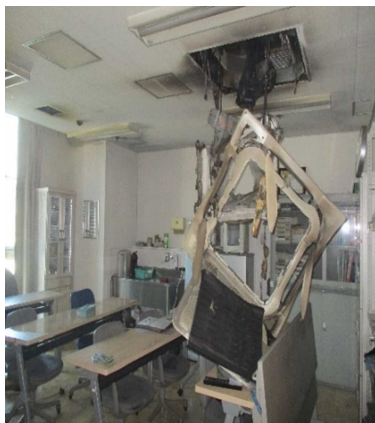
資料管理室兼スタッフルーム
