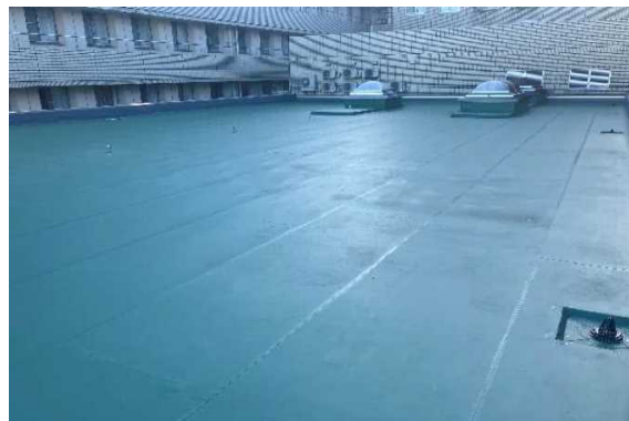
本館4階 屋上防水工事
