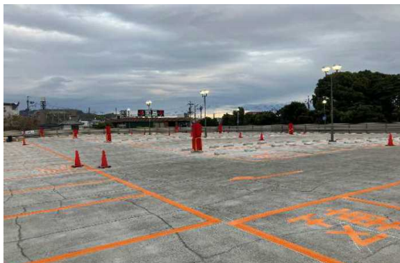
東立体駐車場 屋上防水工事
