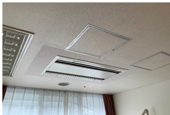
北館5階病室 空調更新工事
