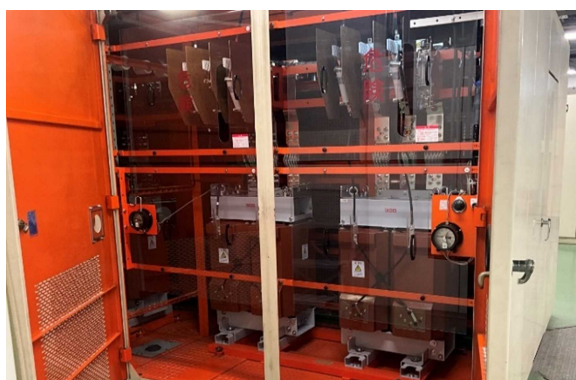
本館電気室 変圧器更新工事
