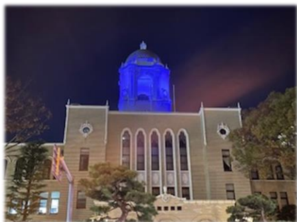
令和5年静岡市役所本館ドーム
